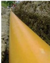
Cevi sa dimenzijama peciziranim prema ISO 4065 sa spoljnim zaštitnim omotačem sastoje se od bazne cevi napravljene od PE 100-RC i zaštitnog omotača napravljenog od polipropilena. Vezivna snaga između zaštitnog omotača i bazne cevi mora biti takva da se snage sečenja koje se pojavljuju tokom polaganja cevi mogu pouzdano prenositi.
